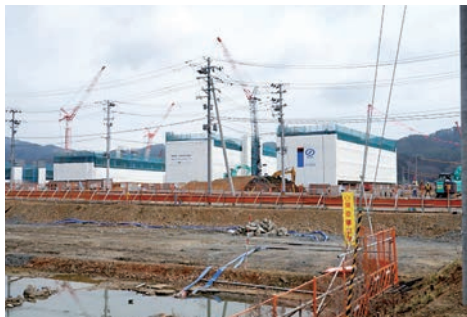
高上げた地盤に建設が進む
