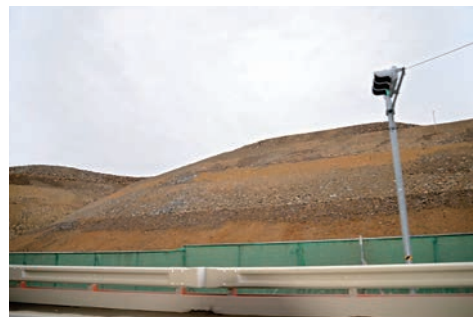
高上げ工事が進む鹿折地区
