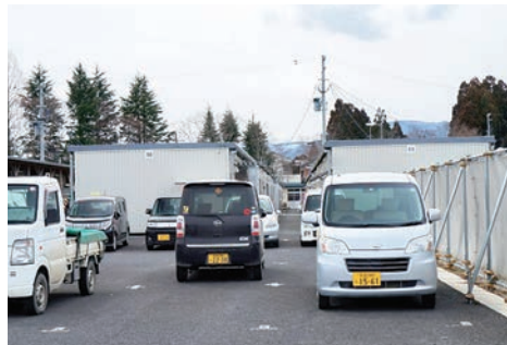
校庭に建つ仮設住宅
